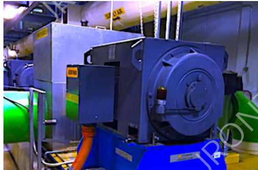
图 1. 300 hp, 885 rpm, 4,160 Vac 感应电机
